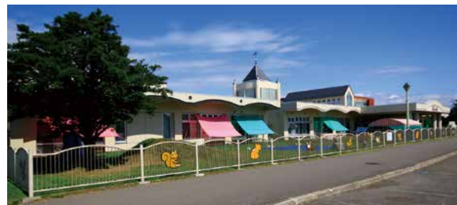
東川町幼児センター「ももがの家」。雄大な大雪山連峰や田園地帯を背景に、外観は平家の水平ラインと吹き抜けの三角屋根や塔で構成し、東川町の景観と融合したスカイラインを形成している。内部は、一日中陽ざしが降り注ぐプレイルームを中心に諸室を配置。子どもたちの活発なコミュニケーションが生まれる温かな空間構成となっている
