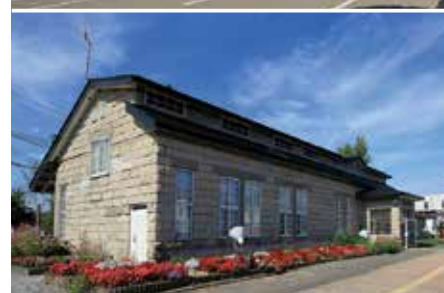
美瑛町建築協定に基づき、建物正面の腰部分(幅木)に美瑛軟石を使った美瑛町駅前通りの街並み。趣のある美瑛軟石づくりの駅舎や公共施設など、随所に美瑛町の歴史や文化を伝える工夫がされている
